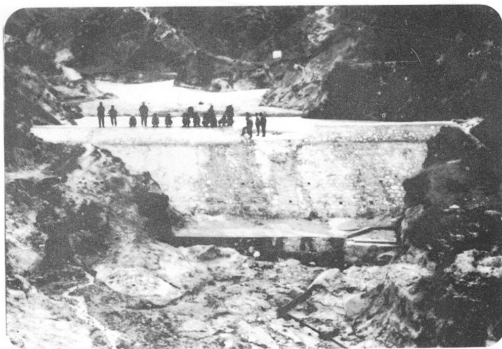
白鸡沟拦沙坝
