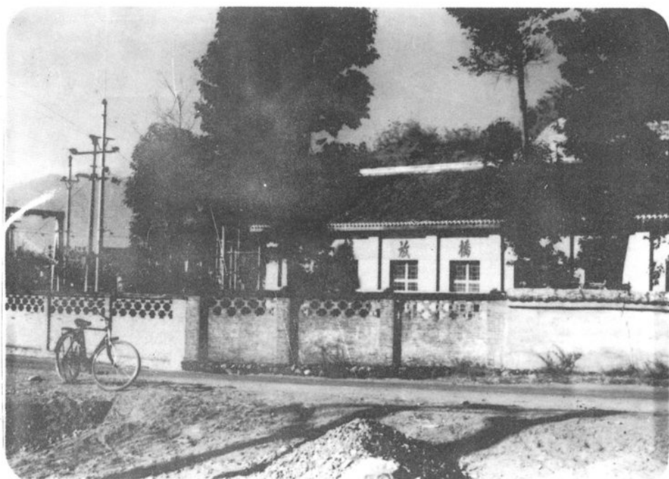
解放桥水电站外景
