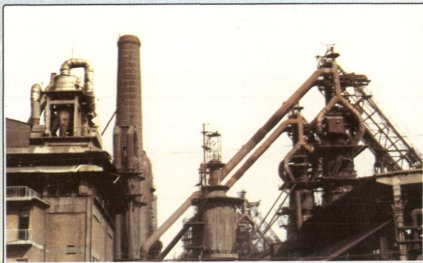
高炉喷吹烟煤安全系统装置
