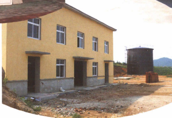
建设中的生物质燃气站
