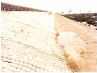
法布混凝土护坡
