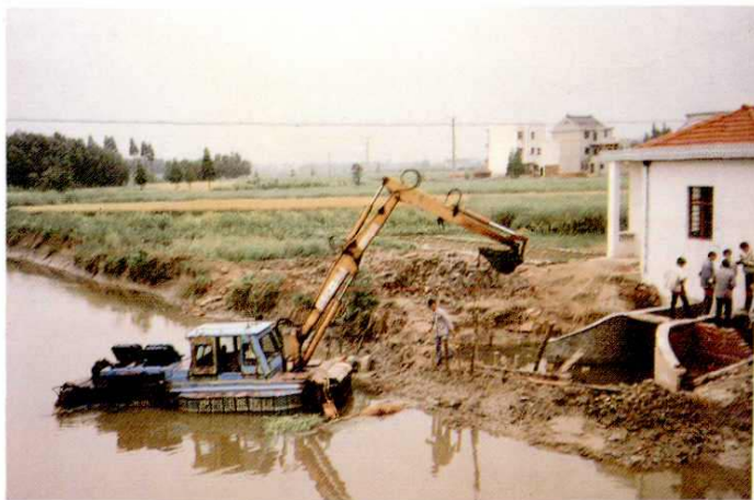
机械疏浚河道
