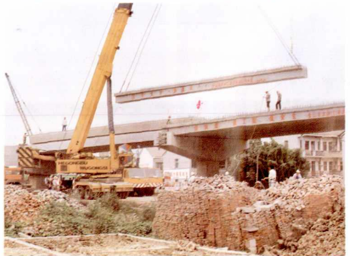
金山县水利工程建筑总公司承建铁路立交桥施工现场
