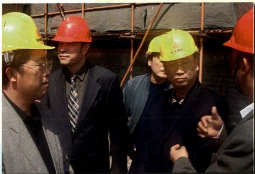
▶ 2007年6月，副区长高德彪（右二）视察正在建设中的800吨生活垃圾处理厂
