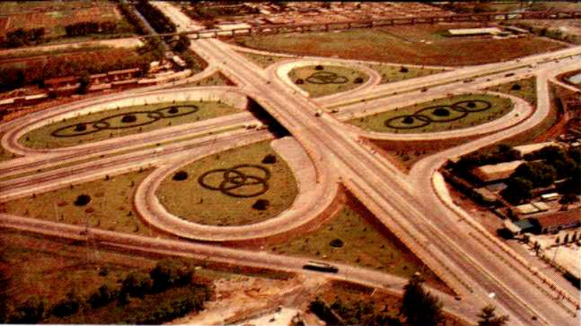
◀ 京津路立交桥
