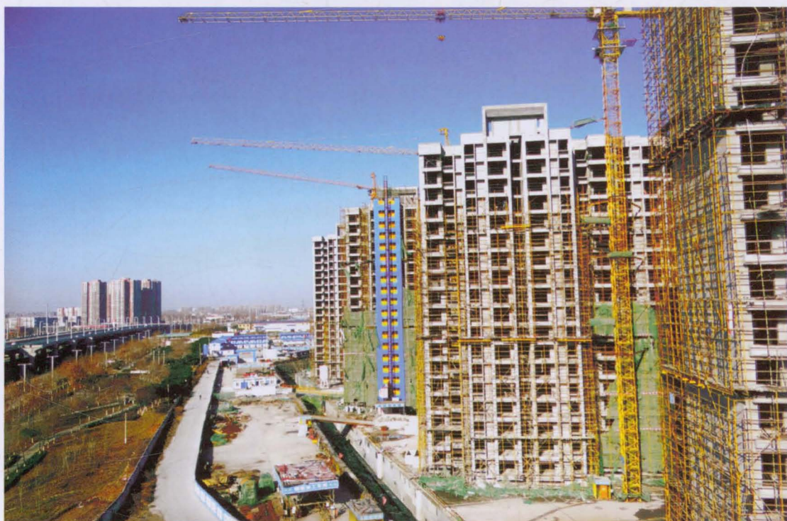
即将竣工的安置房
