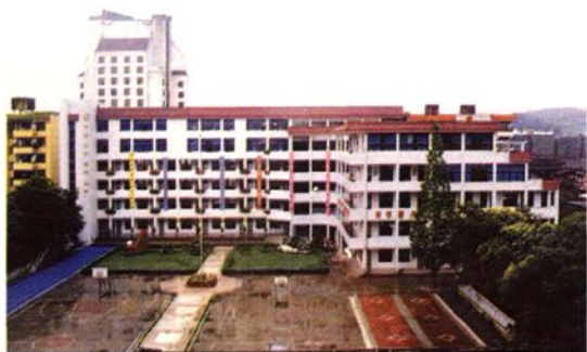
省示范小学——邵武市实验小学。
