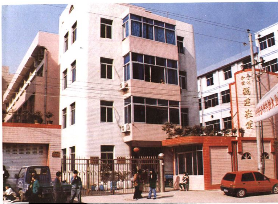
温州市福达鞋业公司是省级技改重点项目，该公司厂房设备均属一流，产品远销世界各地。
