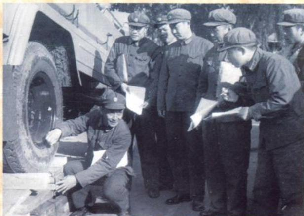
1976年9月，工厂设计生产的国内首辆可载水7吨的CW13型半挂式供水消防车，消防拖车在做性能鉴定
