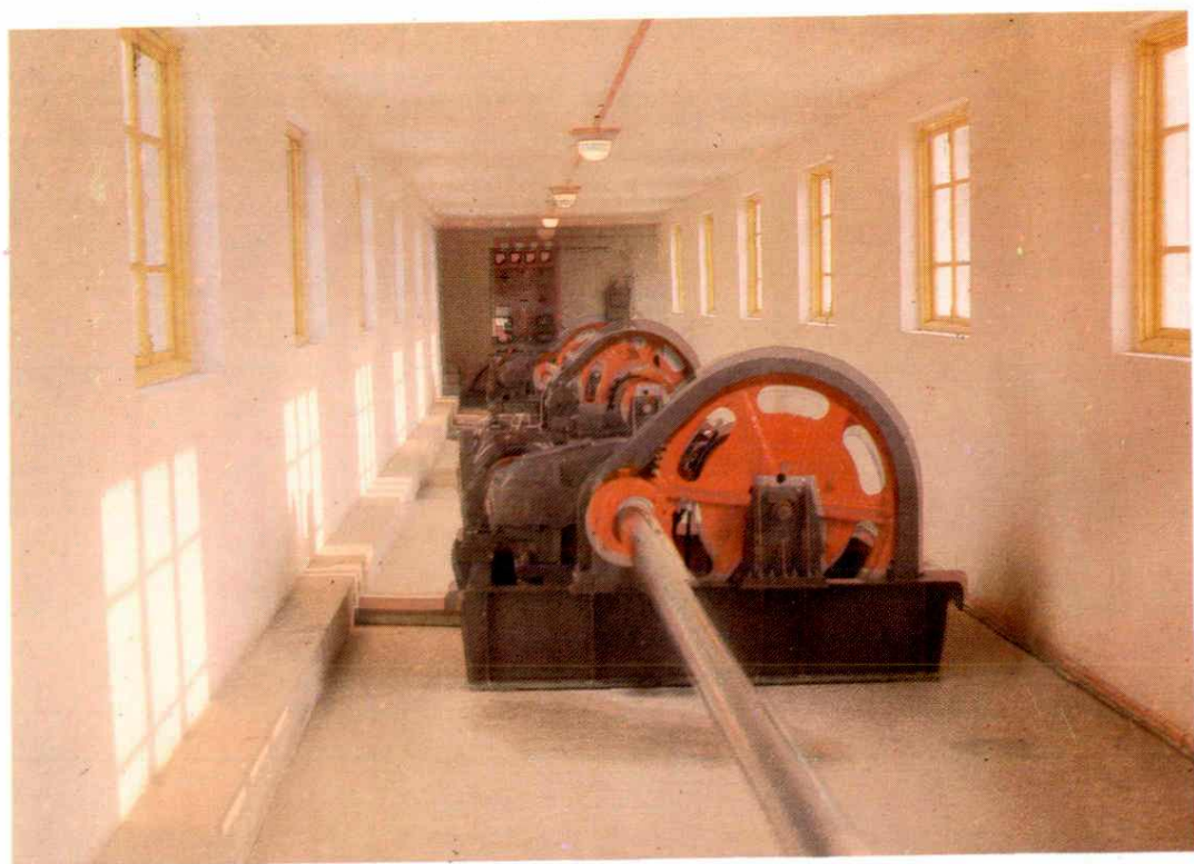
溢洪道启闭机室
