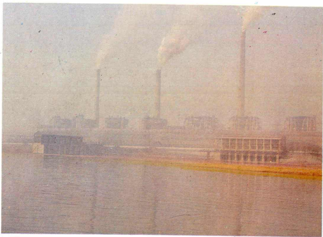
陡河发电厂抽水站
