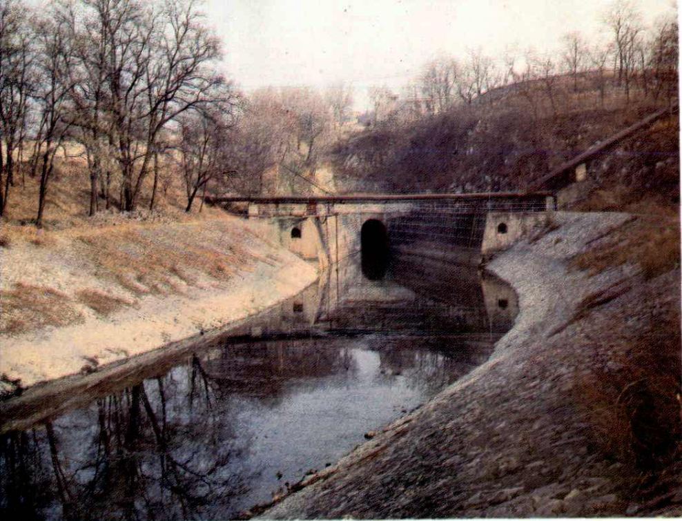
输水洞尾水渠
