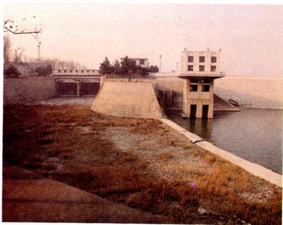
输水洞进水塔和溢洪道
