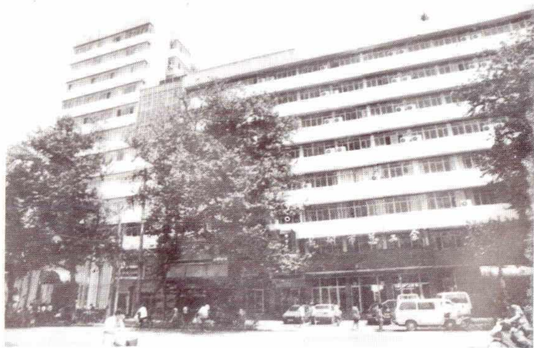
1988年3月,杭州市总工会在原址翻建的新办公大楼正式竣工。
