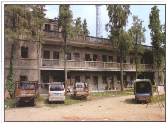
原云楼乡政府办公楼
