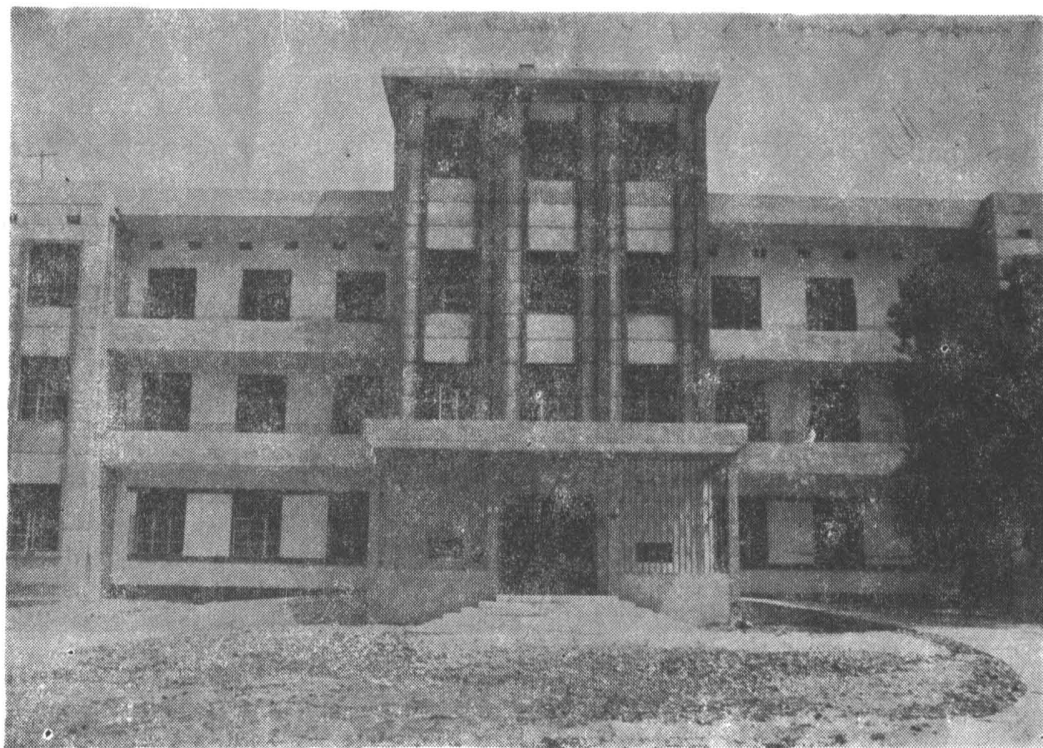
淘沙乡政府机关大楼
