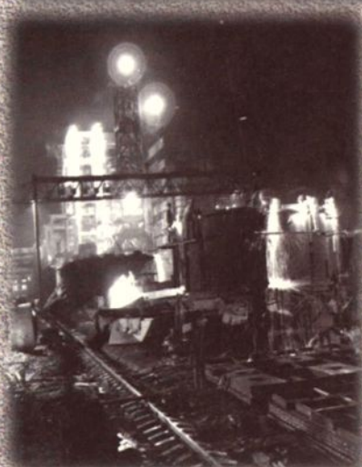
第三期工程建设工地夜景
