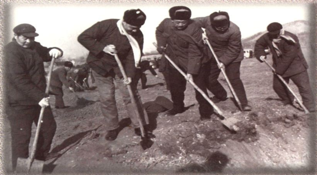
1975年2月20日，徐州发电厂 第一期工程正式破土动工。
