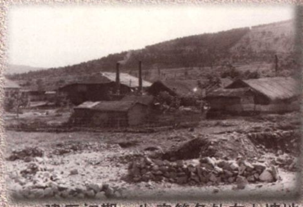
建厂初期，生产筹备处在山坡地 搭建的临时工棚。
