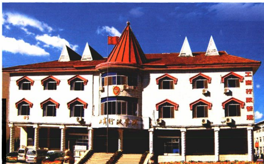
1998年1月6日 ➤ 启用的旭日小 区一号办公楼 (2007年9月19日停用)
