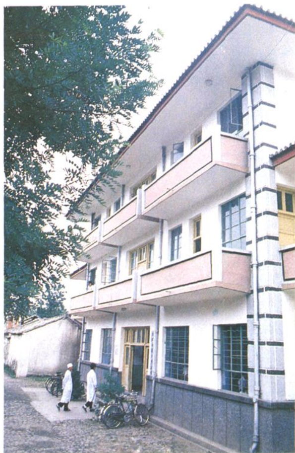
▲大理市第二中医院门诊楼
