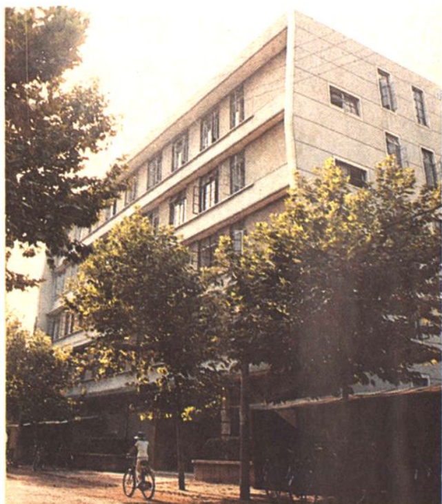
港务管理处办公楼
