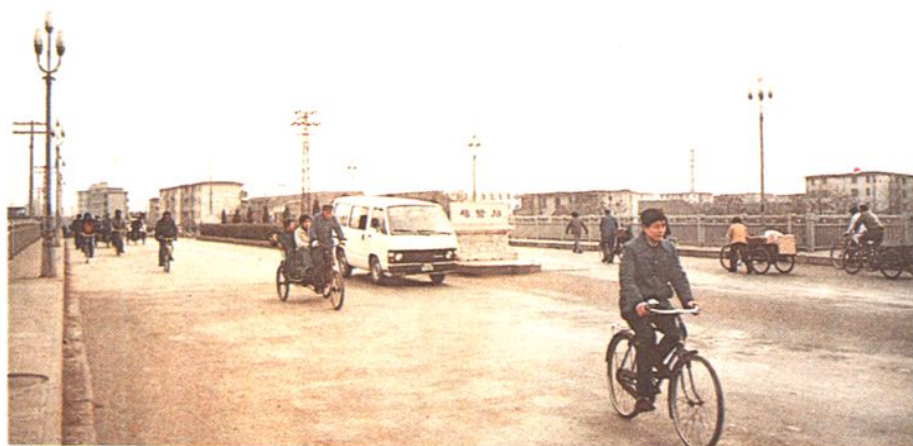
位于市区328国道上的招贤桥
