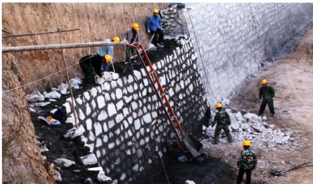
▲ 崖崩塌治理工程现场
