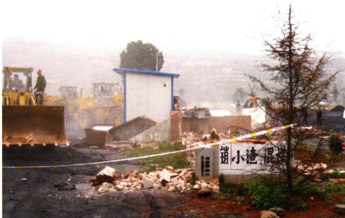
违法占地拆除现场 ▶
