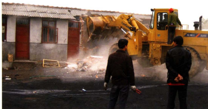
◀ 违法占地拆除现场
