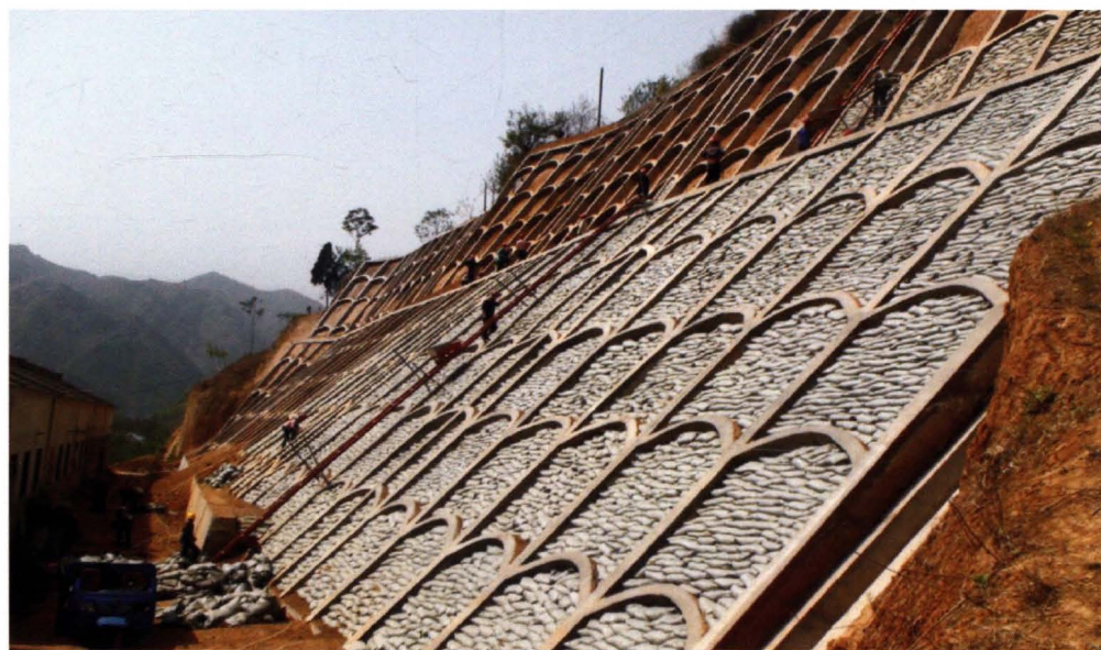
▲ 地质灾害治理工程施工现场
