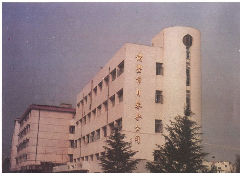
自来水厂办公楼
