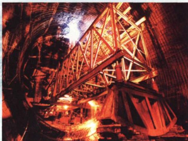
贵州引子渡水电站引水隧洞混凝土衬砌(2004年)
