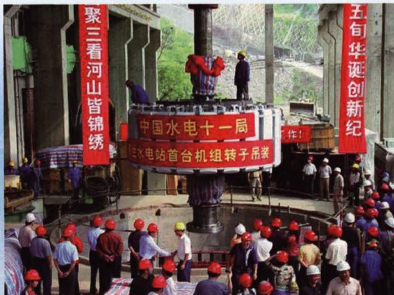
2006年12月，云南土卡河水电站首台5.5万千瓦机组转子吊装
