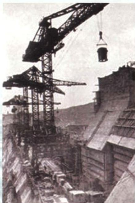
1959年，三门峡工程“大干一百万”时的混凝土浇筑现场
