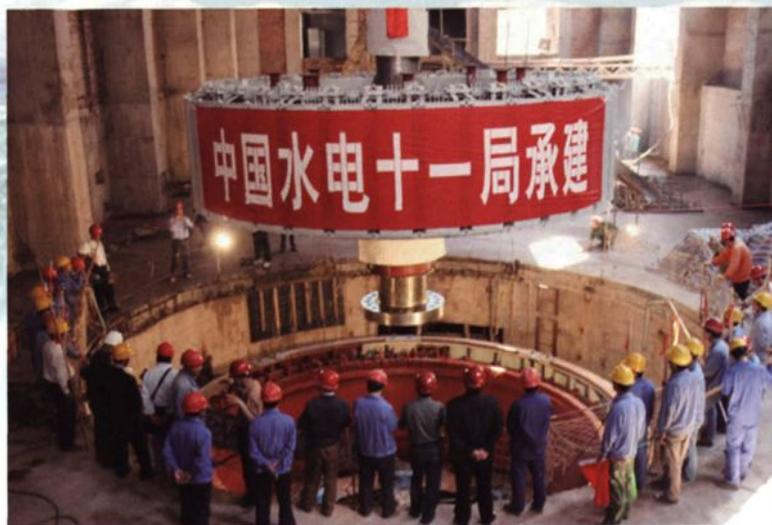
2006年3月，云南崖羊山水电站首台6万千瓦机组转子吊装
