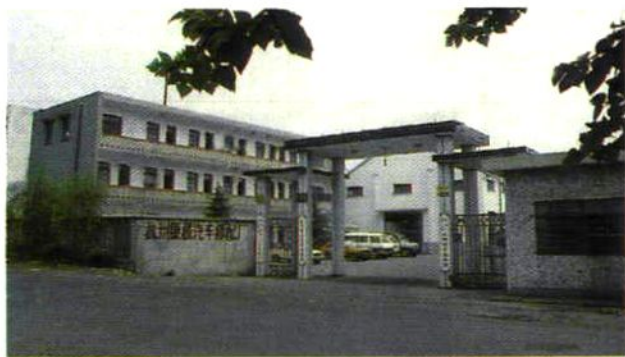
杭州康桥汽车修理厂
