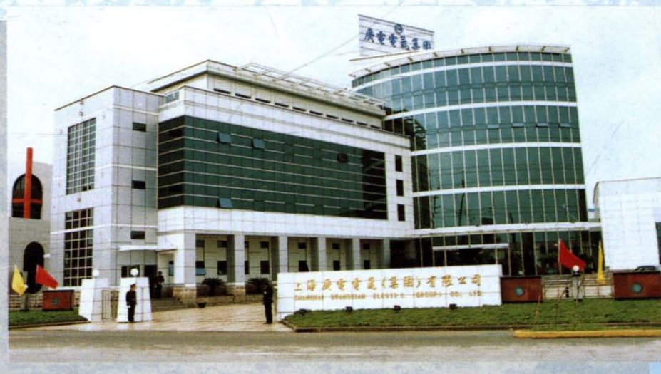
△ 上海广电电气(集团)有限公司
