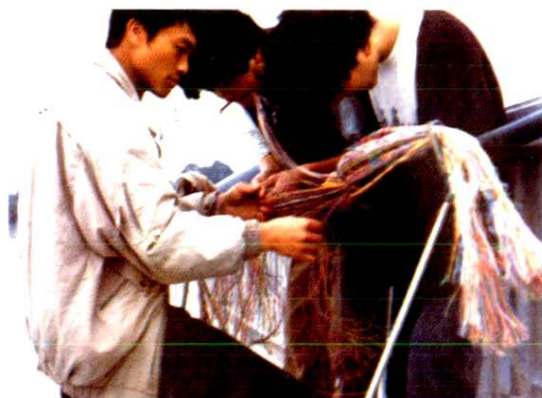
市话电缆接续
