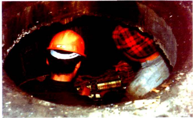
人孔内电缆接续
