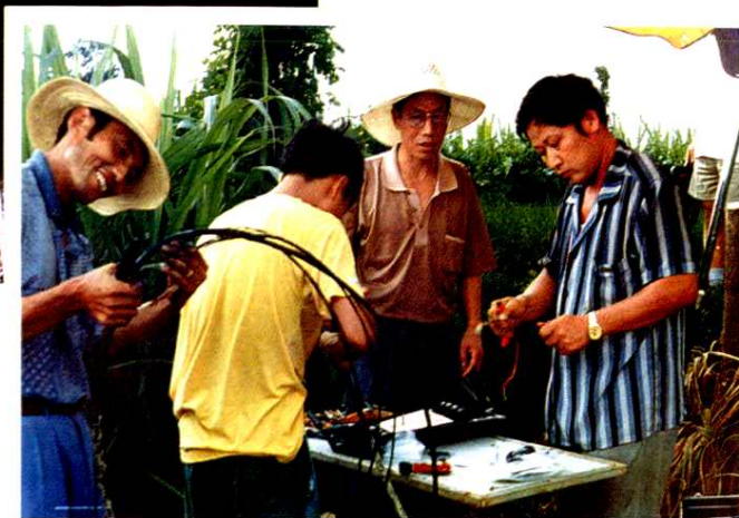
工程技术人员在野外进行光缆接续
