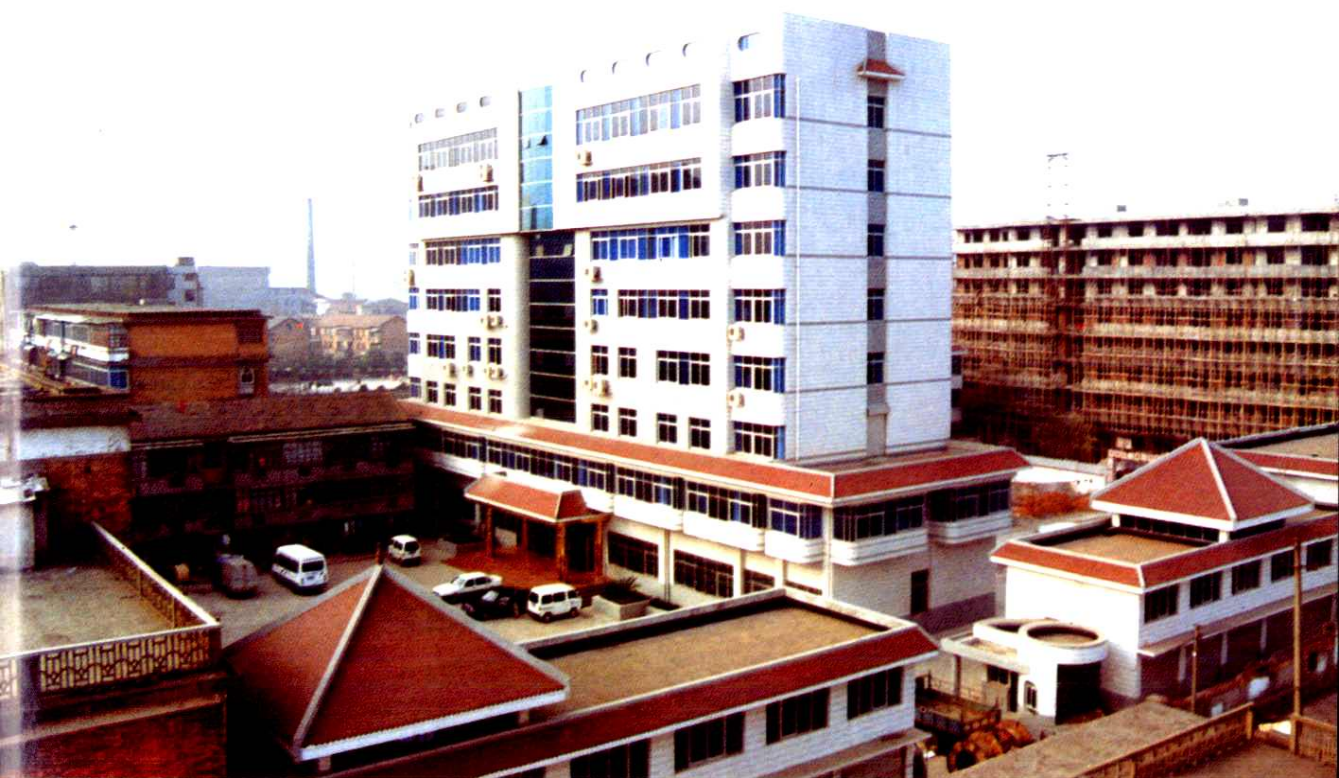
江西省邮电建设工程局全景
