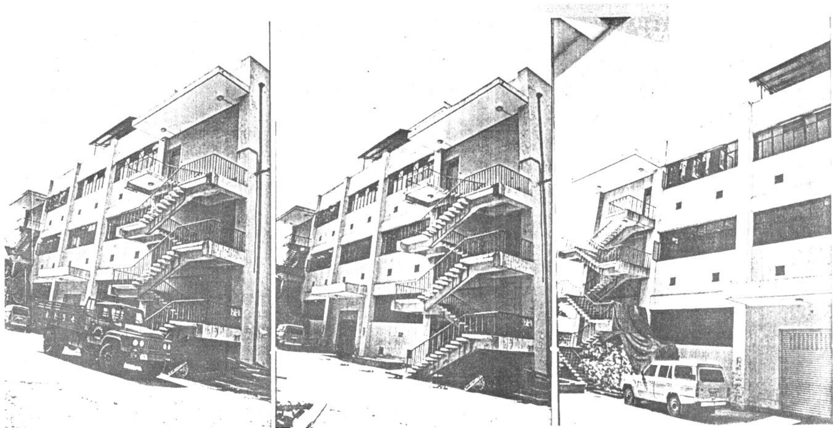
州中药材公司现代化一号仓库
