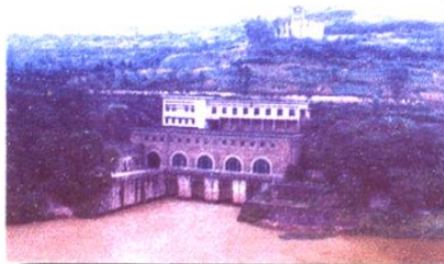
龙溪河梯级之龙头——狮子滩水电站，左：发电厂房，右：堆石坝与水库
