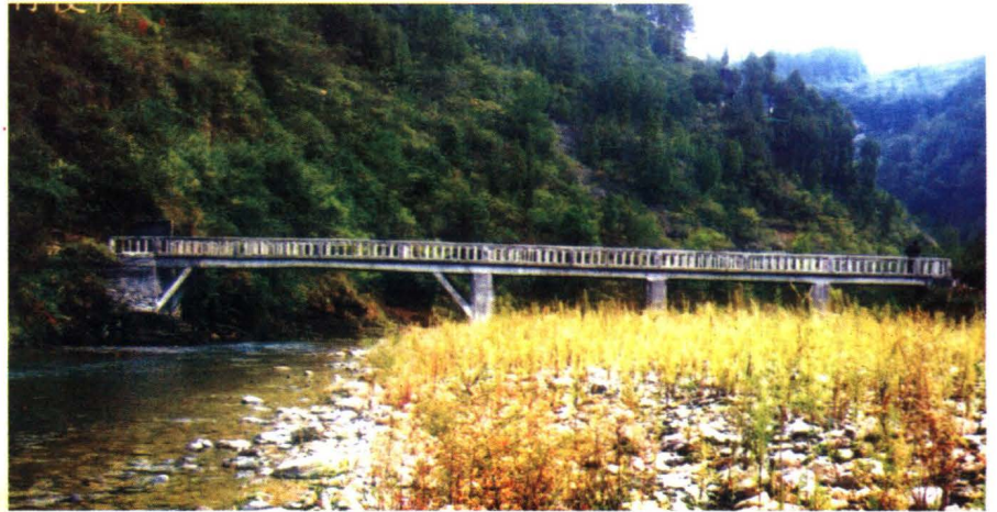
三桥镇永锡村群众 集资投劳修建的人行 桥——梦圆桥(2005年)
