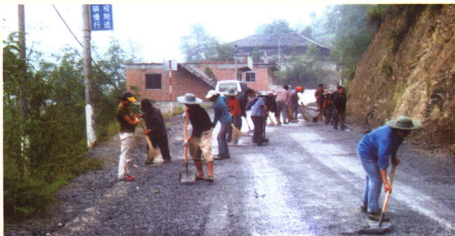
巴渔至阳溪公 路改造施工现场
