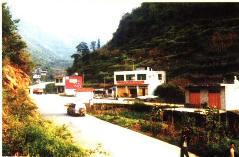
道南公路改线与原 公路分道处——三角坝
