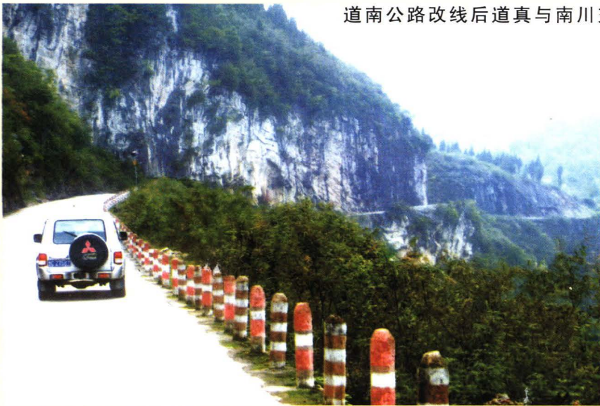
207省道公路改造瓮溪段（1999年）
