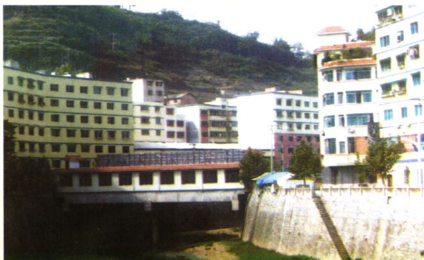
跨玉溪河人行桥—— 玉银桥（2004年）
