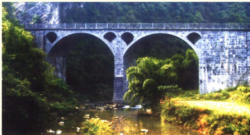
道南公路改造新建的 桂花大桥（2002年）
