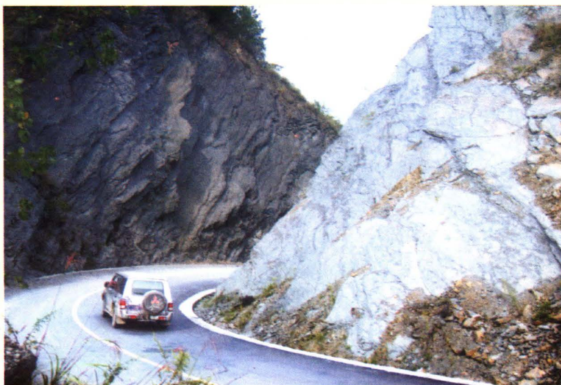
道南公路在石人地段 开凿的大槽口
