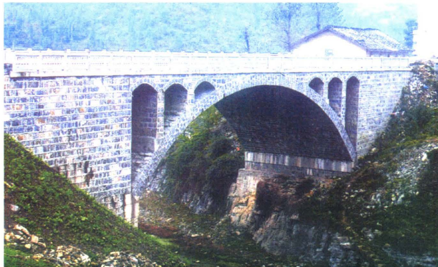
道武公路改造新 建的双碑桥(2004年)
