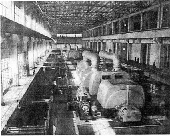
富拉尔基第二发电厂汽轮发电机组。
