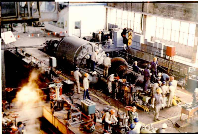
南京第二热电厂职工检修发电机组
