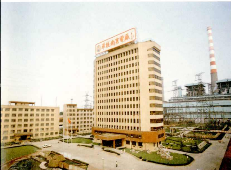
华能电厂前区办公楼
