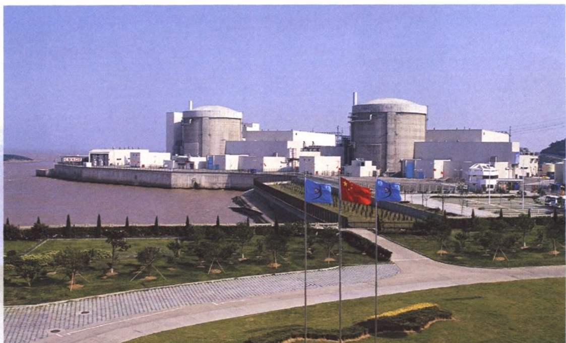
秦山核电站三期工程
