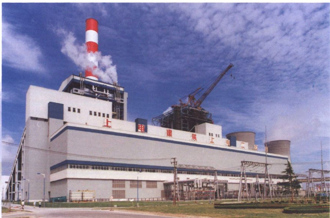
上海吴泾热电厂八期扩建工程
