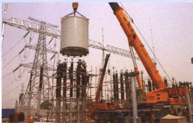
2002年，建设中的上海500千伏 泗泾变电站
