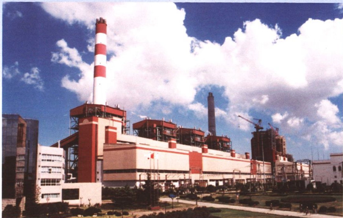
建成的上海外高桥电厂和建设中的外高桥电厂二期工程
