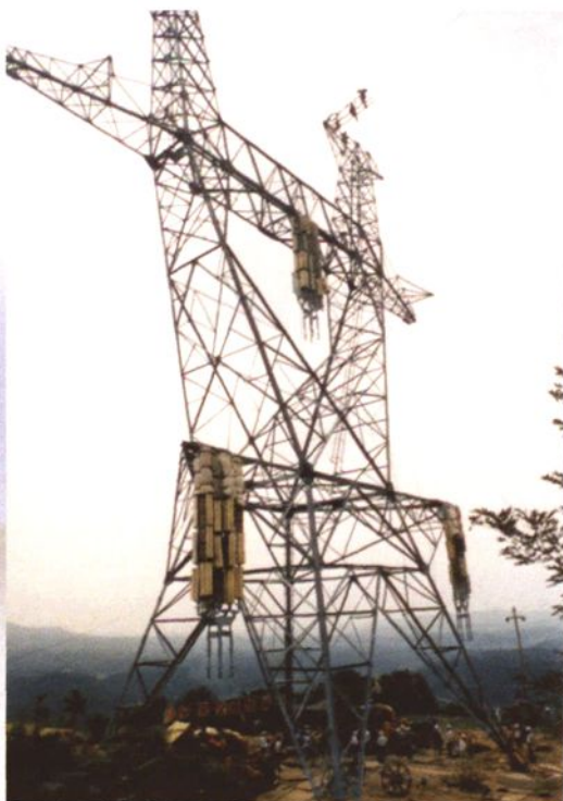
建设中的镇江跨越长江500千伏 输电工程
