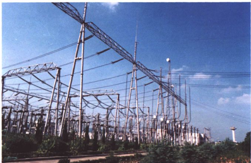
1992年8月，安 徽500千伏繁昌变 电站扩建工程建成 投运
