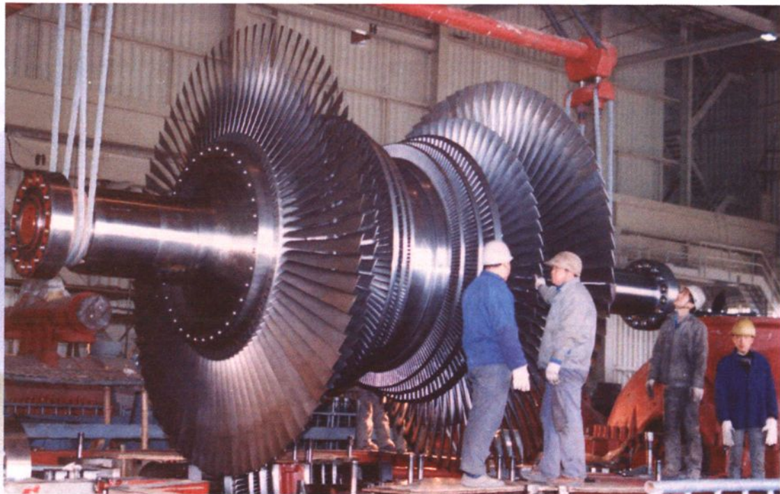
上海石洞口第二发电厂 60 万千瓦汽轮发电机组安装现场
