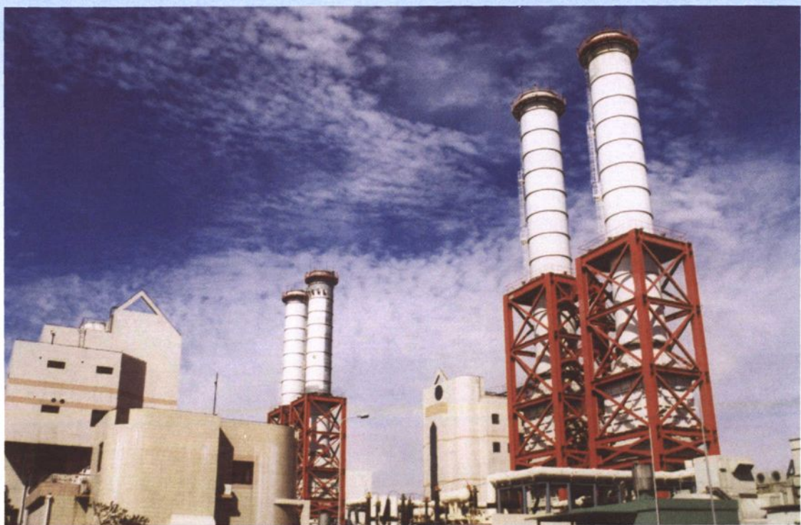
上海闸电燃气轮机发电厂
