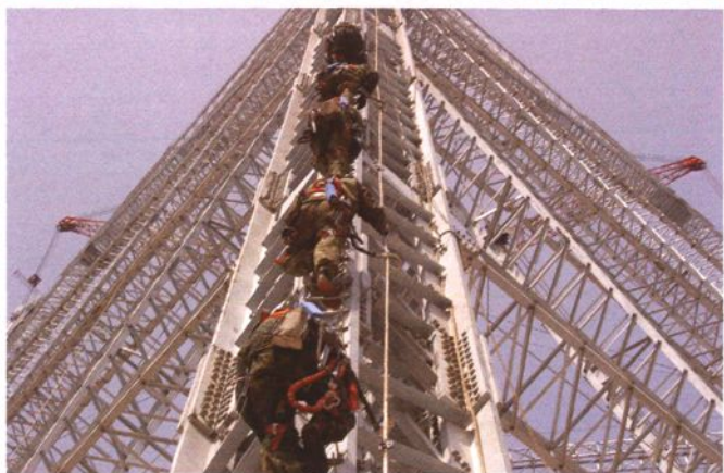
2002年，建设中的江阴长江大跨 越工程立塔施工
