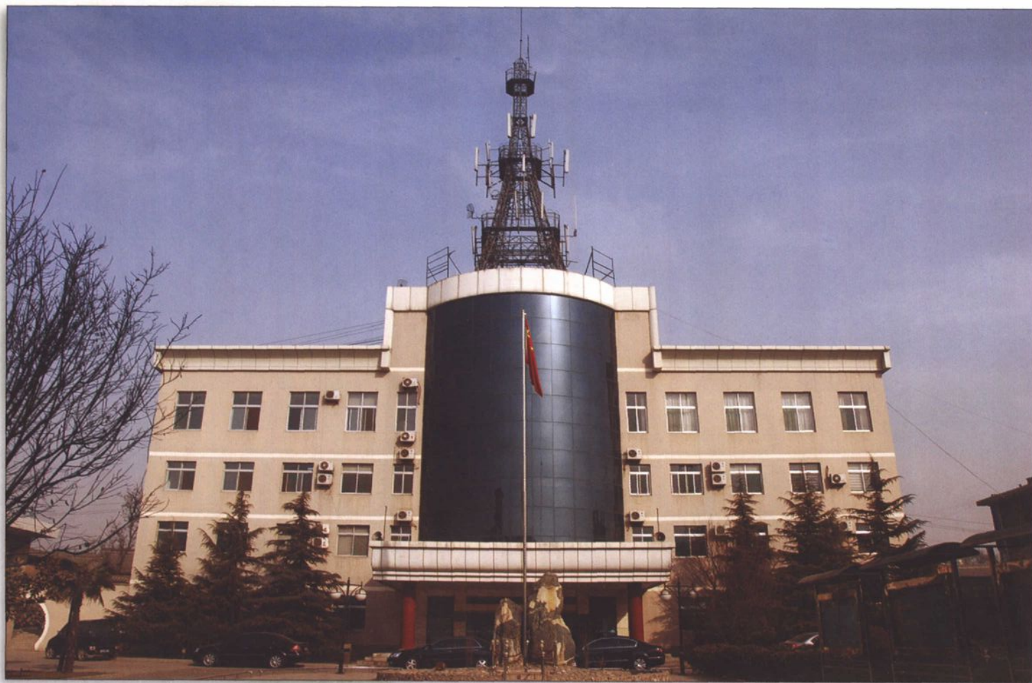
新绛县电业局生产调度大楼
