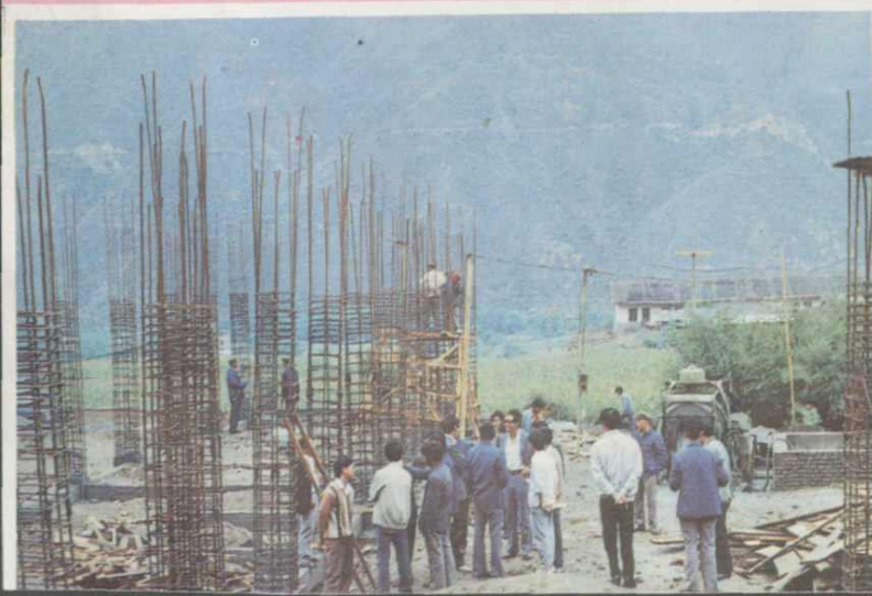
巴塘地震后重建家园施工现场一角
