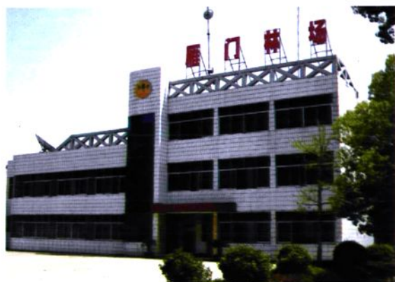
雁门林场办公楼
