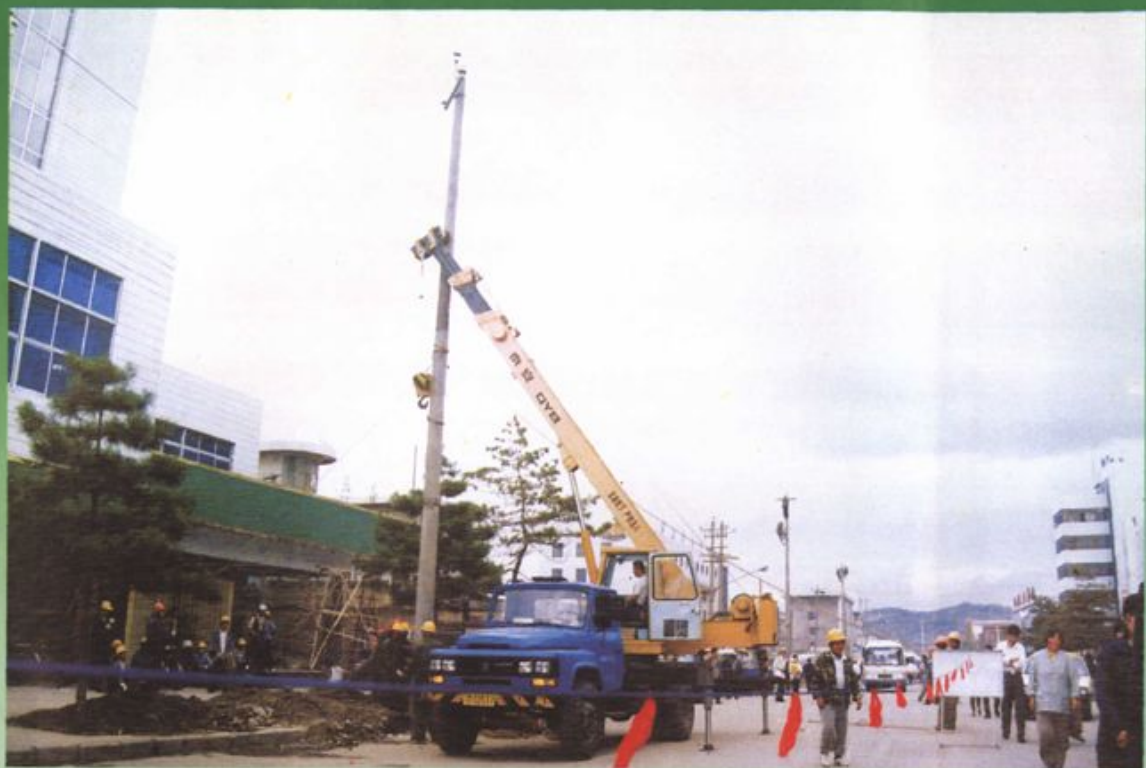
2002年城市进行电网入地工程
