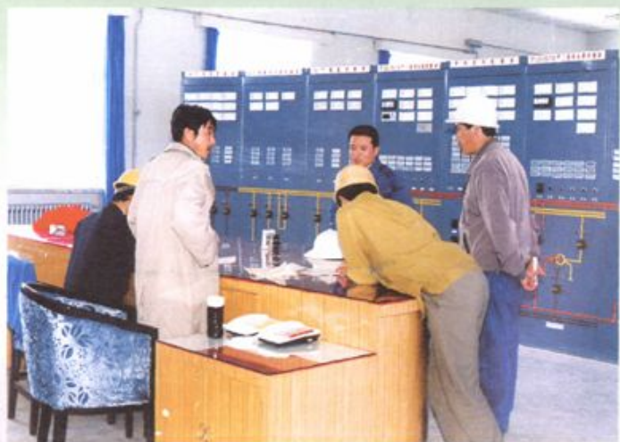
2001年局领导对变电站进行安全检查
