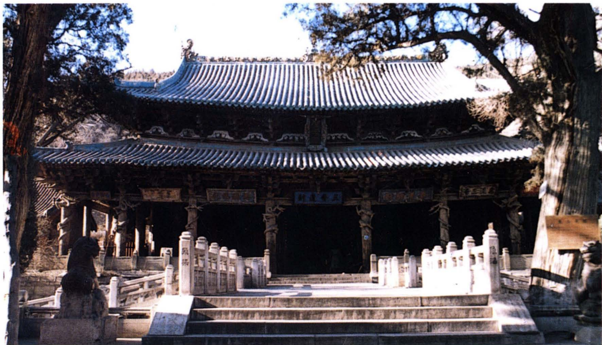
太原晋祠宋代减柱法木结构建筑圣母殿
