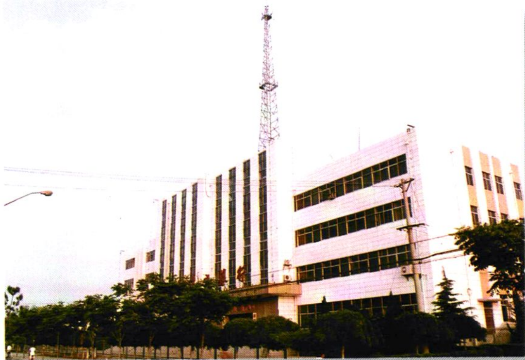
1988 年落成的建设银行新乡市分行办公楼 (新乡市平原路东段 341 号)
