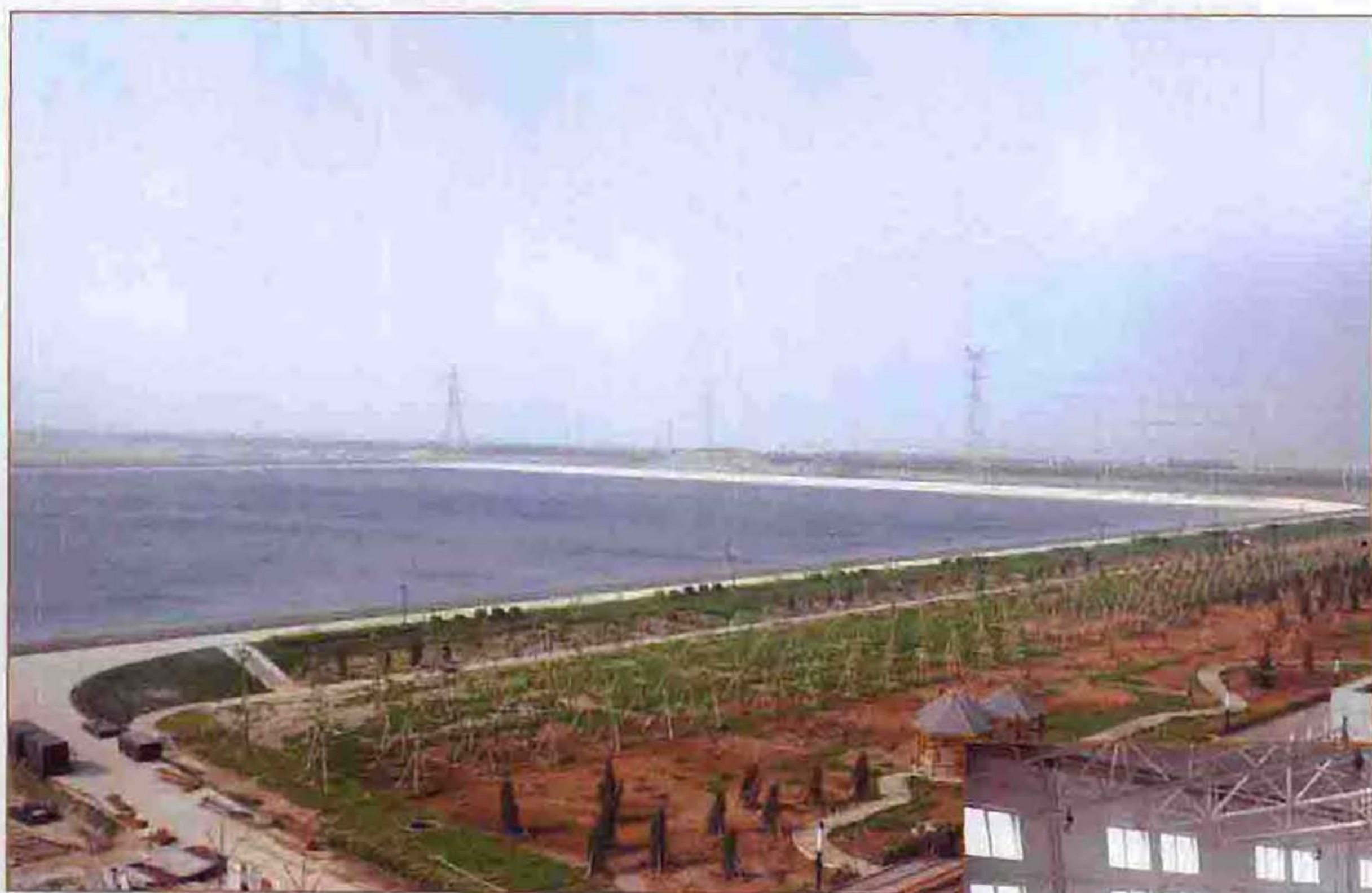
唐山市曹妃甸工业 区供水有限责任公司 蓄水池
