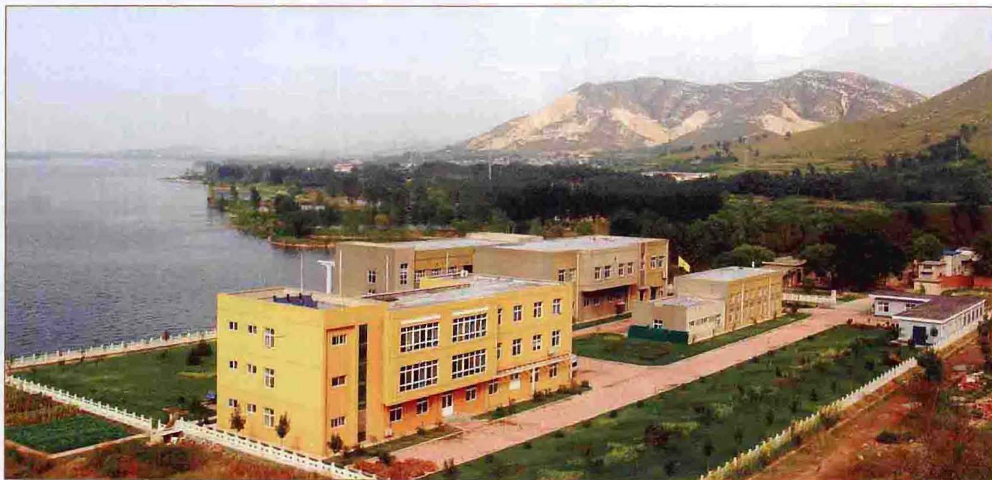
唐山市曹妃甸工业区供水工程陡河水库取水泵站
