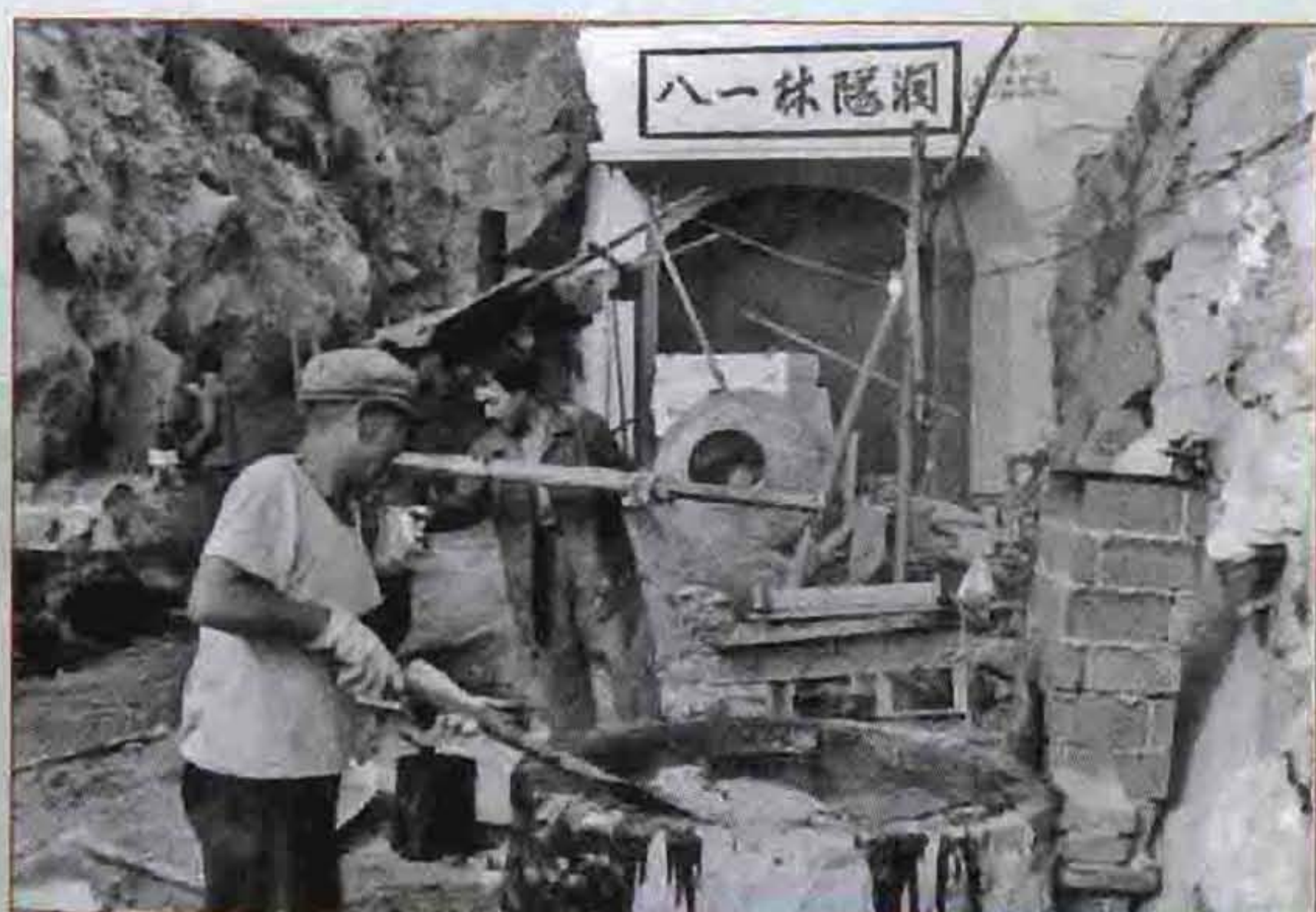
八一林隧洞施工现场
