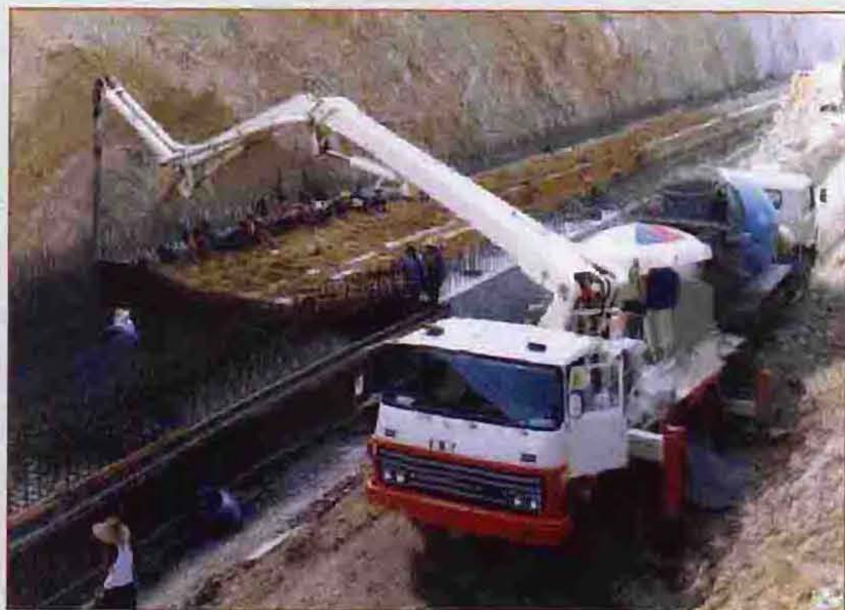
照燕洲埋管混凝土搅拌运输车与混凝土泵车联合作业
