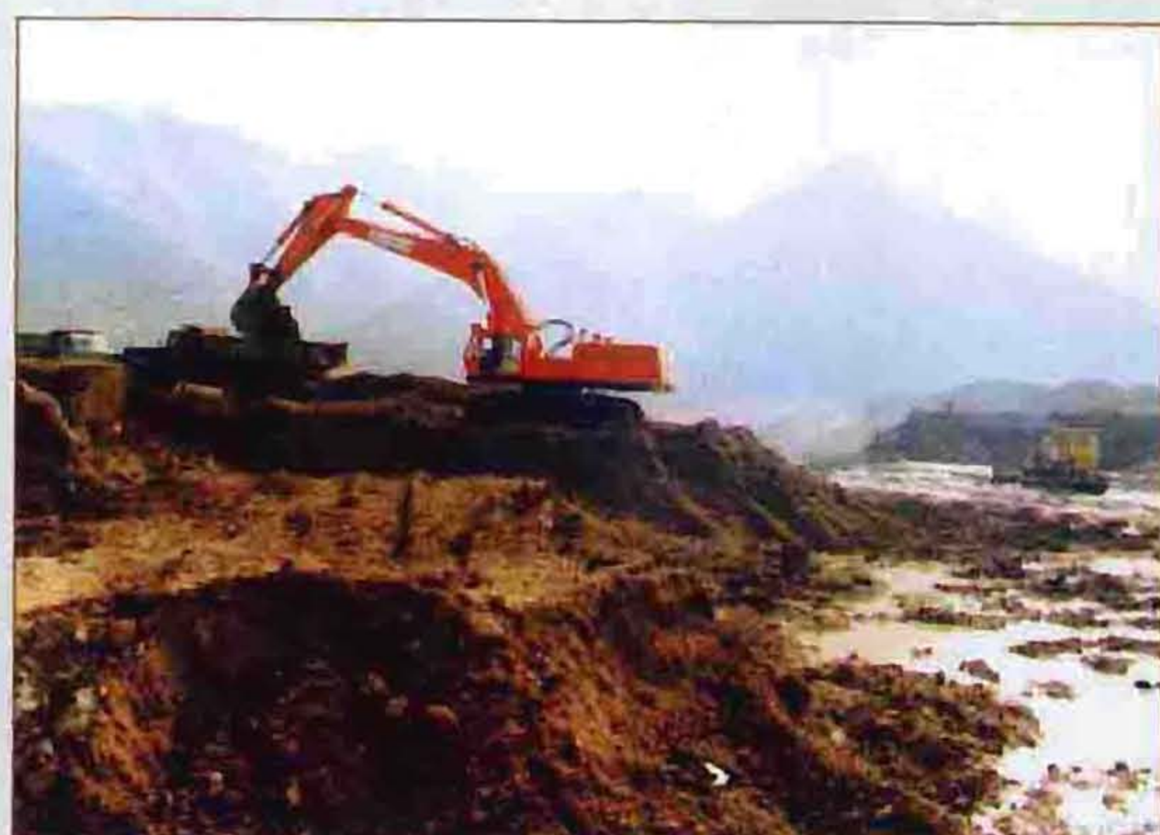
引滦入还段淤泥河开卡疏竣开挖现场
