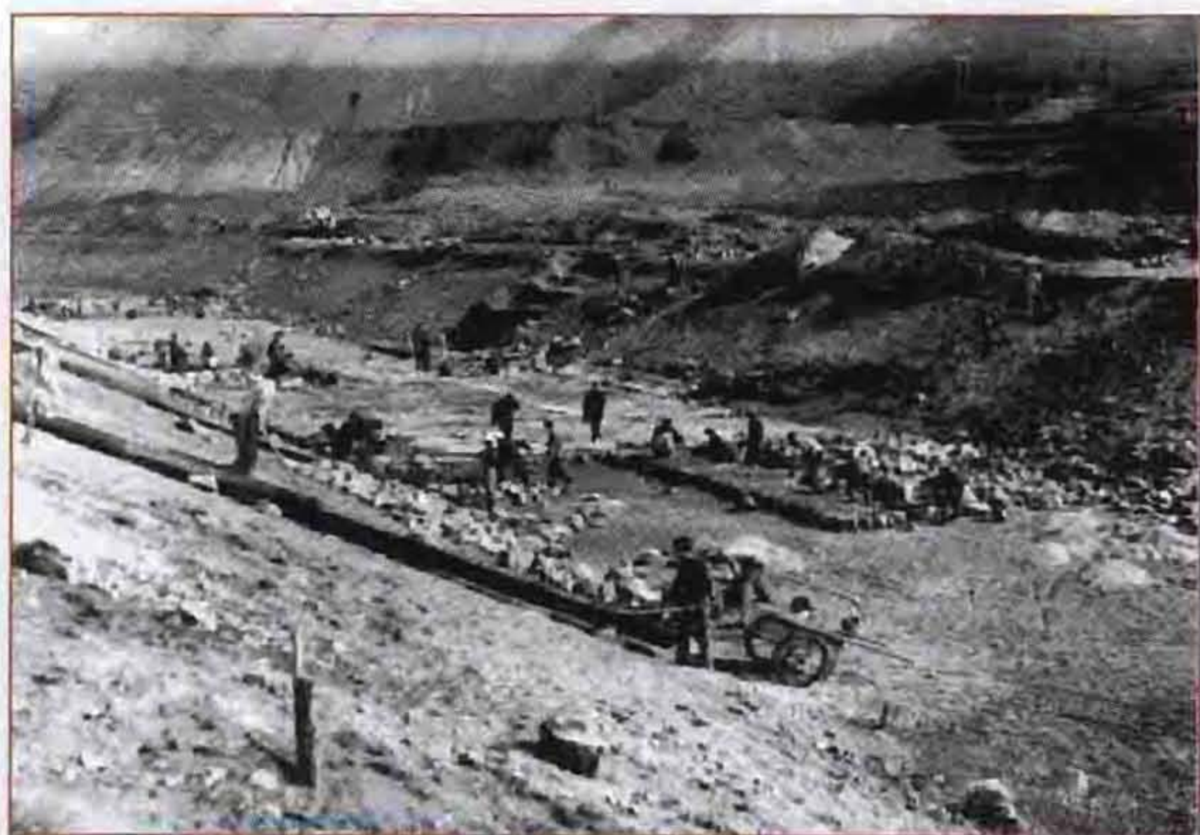
淤泥河开卡浆砌石砌筑渠底和边坡
