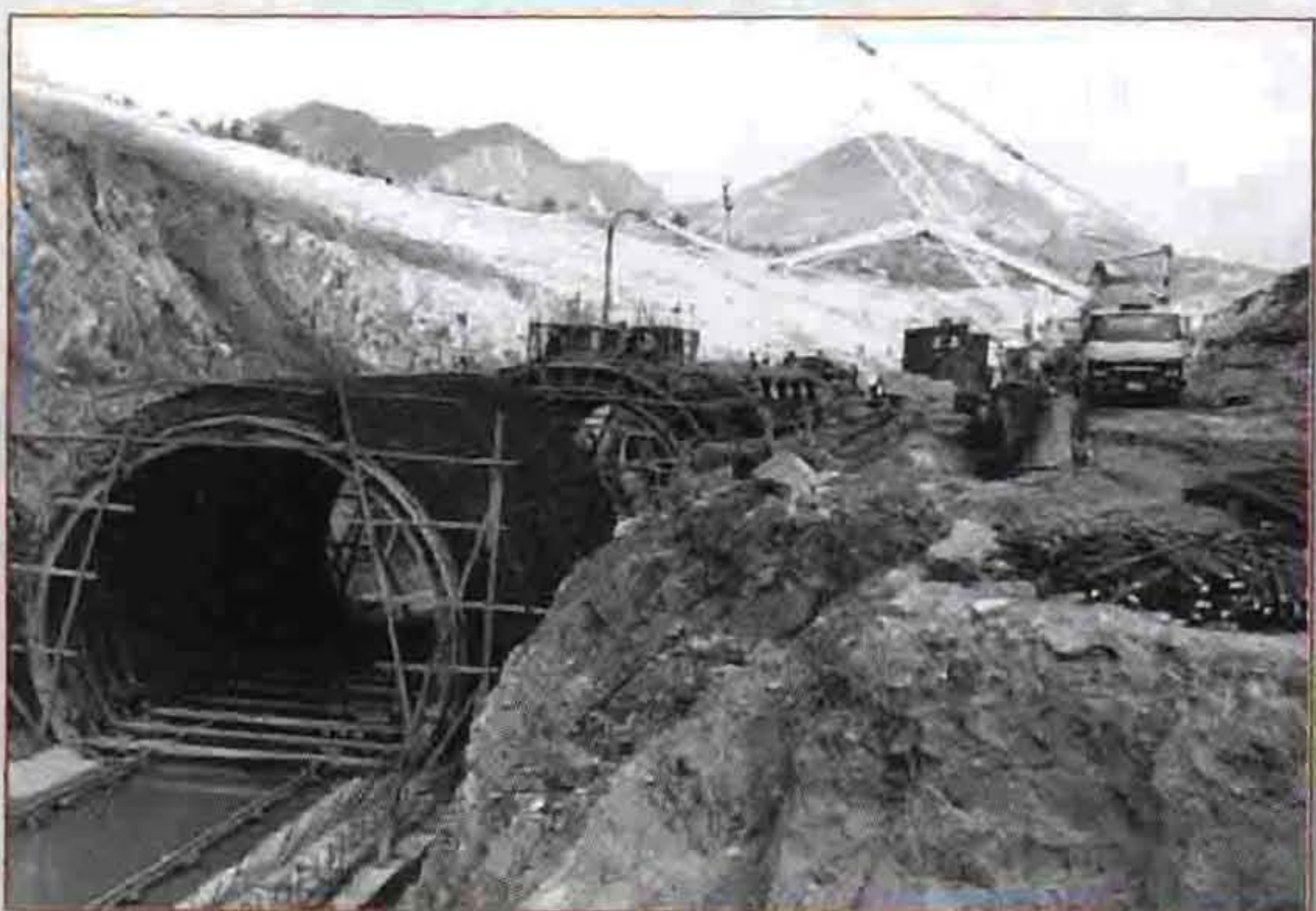
赵庄埋管吊装外钢模板
