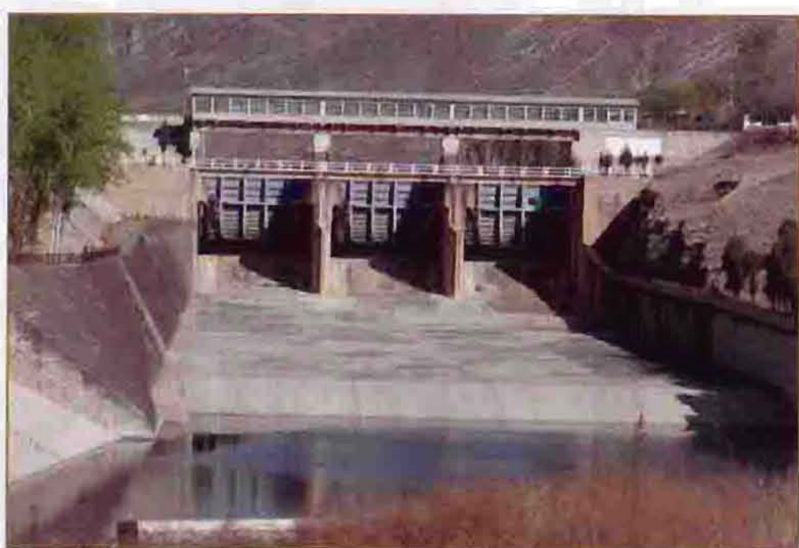
邱庄水库溢洪道
