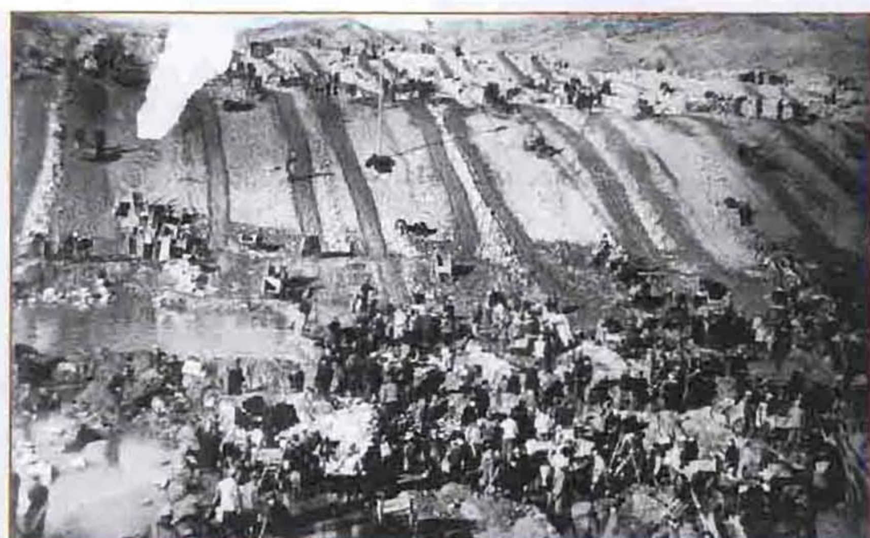
大黑汀水库建设
