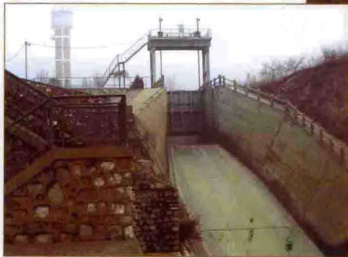
姚庄电站主渠道输水渠
