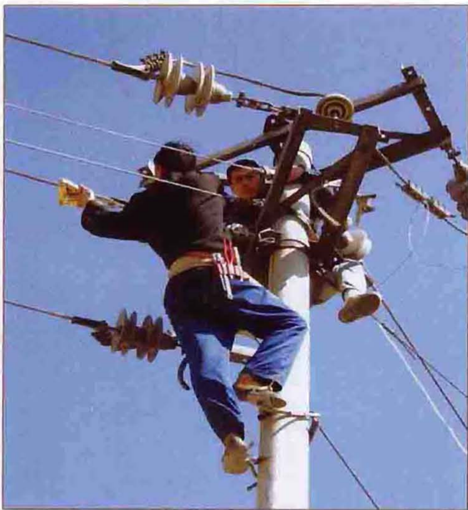
姚庄电站线路维修
