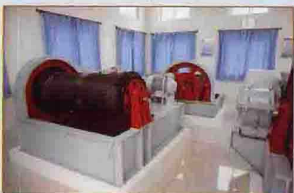
陡河水库机房
