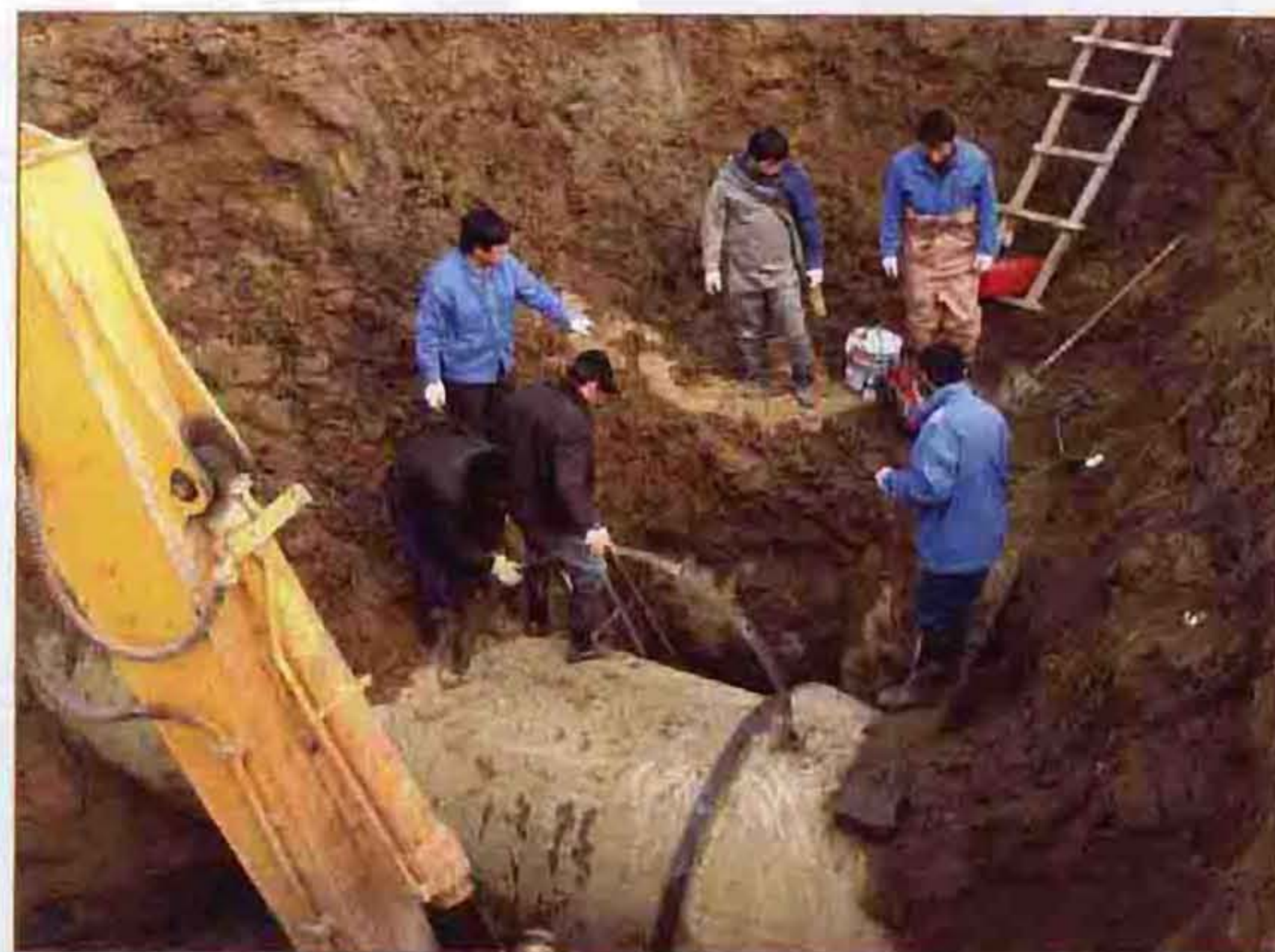
曹妃甸供水管线抢修
