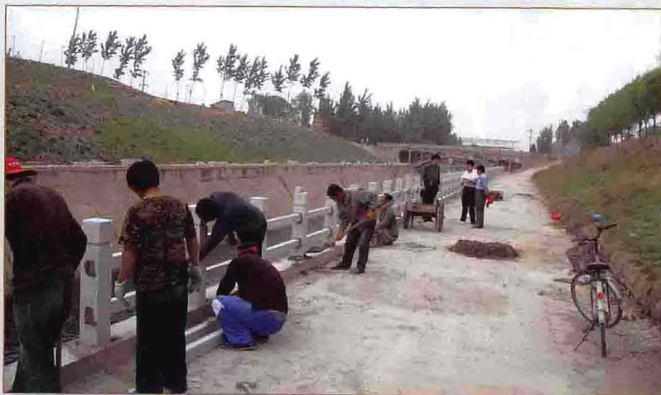
迁西渠道管理处渠道栏杆维护
