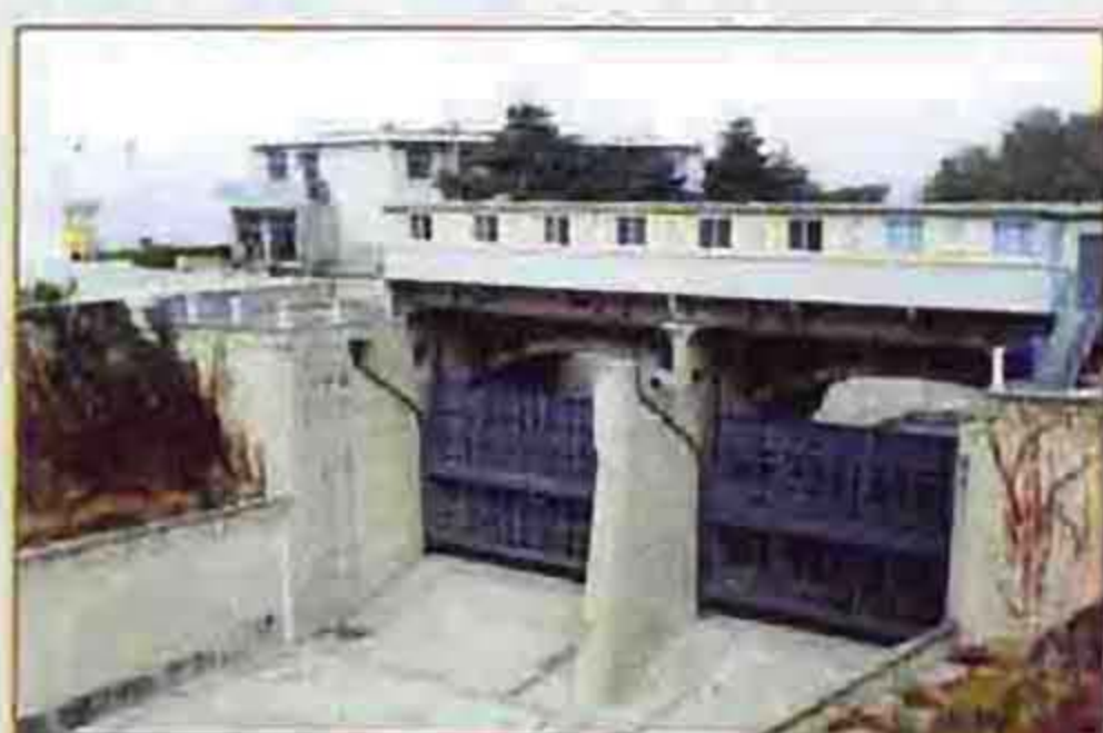
陡河水库溢洪道
