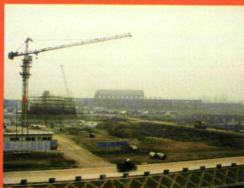
荆门三期扩建工程在建
