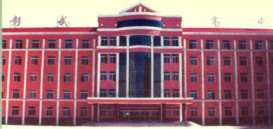
教学、实验综合楼一侧
