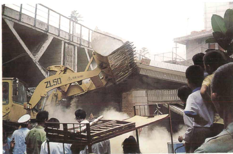
拆除违章建筑
