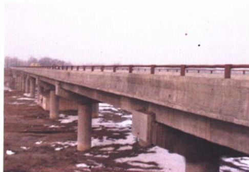
重建的卧牛大桥
