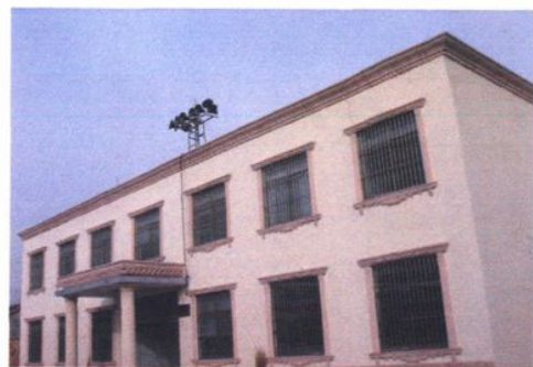
屈北村办公楼
