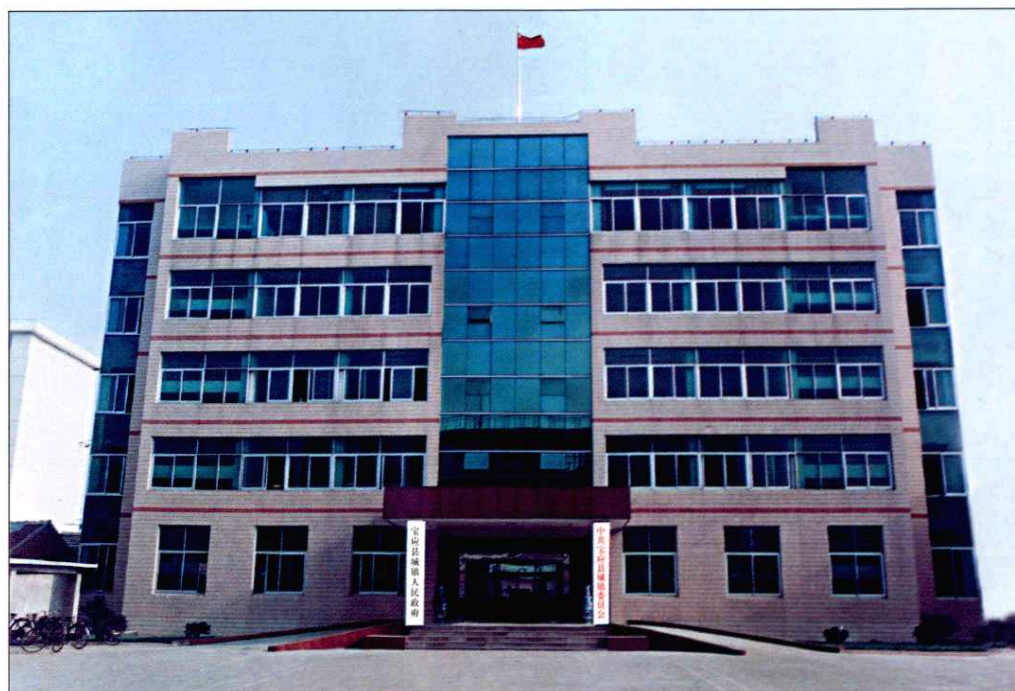
▲ 城镇机关办公楼
