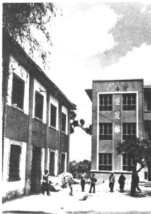
通海县人民医院住院部
