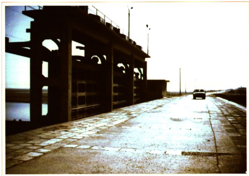
姚塘子扬水站进水闸
