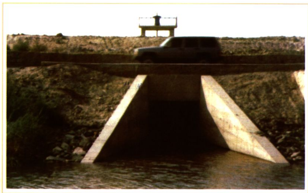
北大港水库沙井子放水闸
