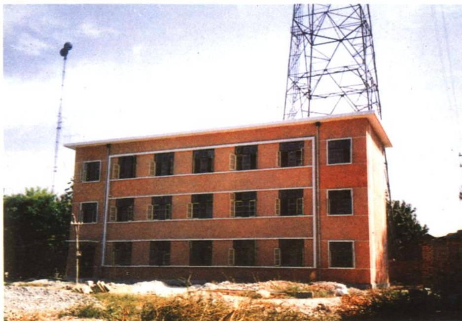
菏泽修防处施工中的通讯大楼
