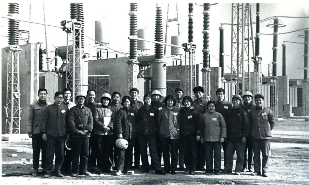
1981年，电科院领导和科技人员在500千伏平武输变电工程现场进行启动调试
