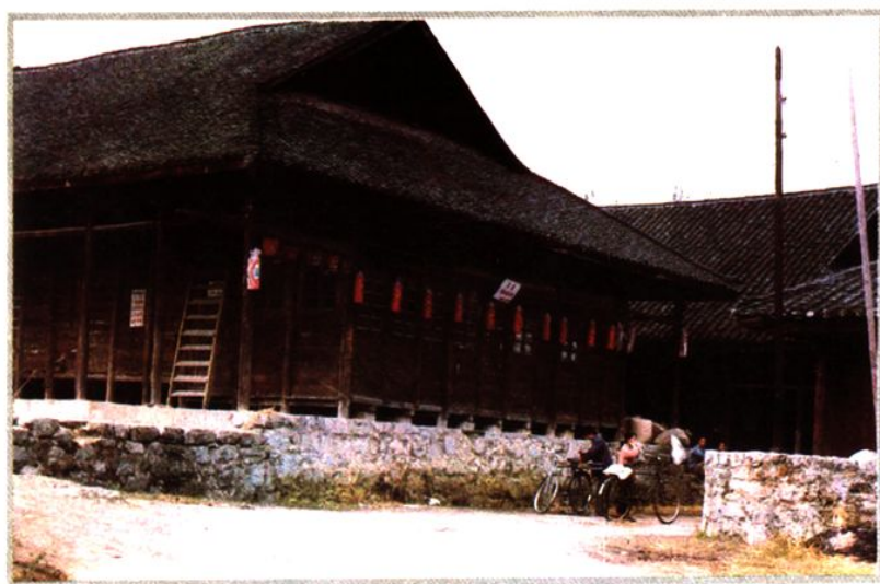
风冈县粮食局龙潭区粮管所建于1952年的木板仓库
