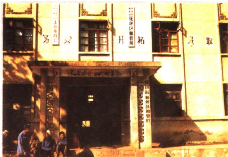
花坪区粮管所办公楼
