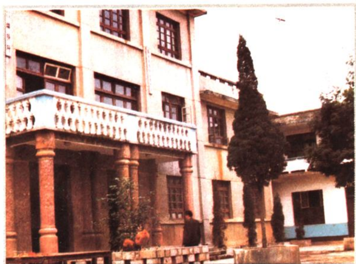
绥阳粮管所办公楼一角
