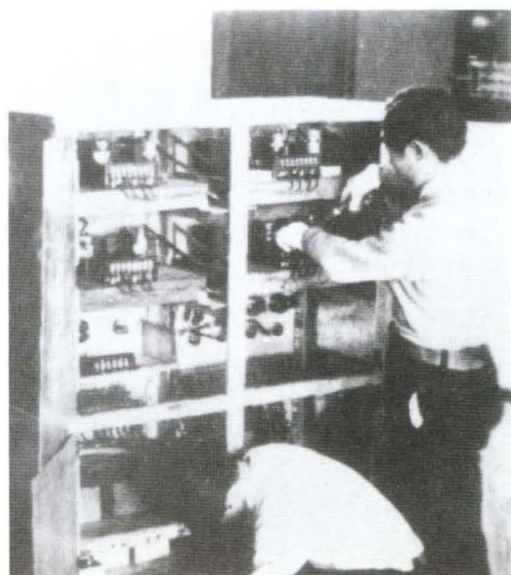
热河人民广播电台技术人 员正在检修设备。
