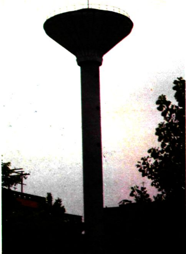
自来水公司倒锥壳水塔
