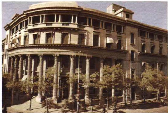
天津市总工会办公楼
